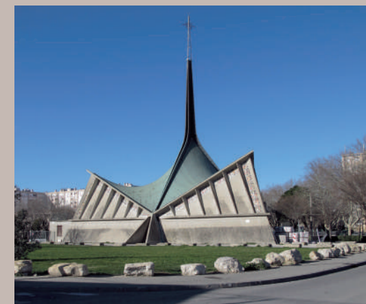
Église Saint-Joseph-Travailleur Guillaume Gillet, architecte, 1967-1969
