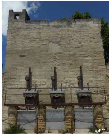
Vannes de la Poterne des teinturiers
